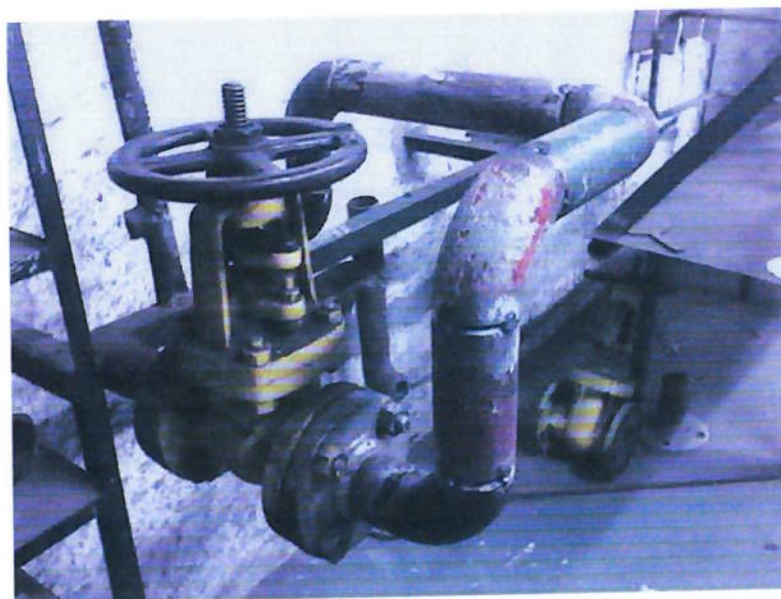
Figura 5 – Pequenos pontos de solda nas peças do conjunto (fonte: Abraman)
