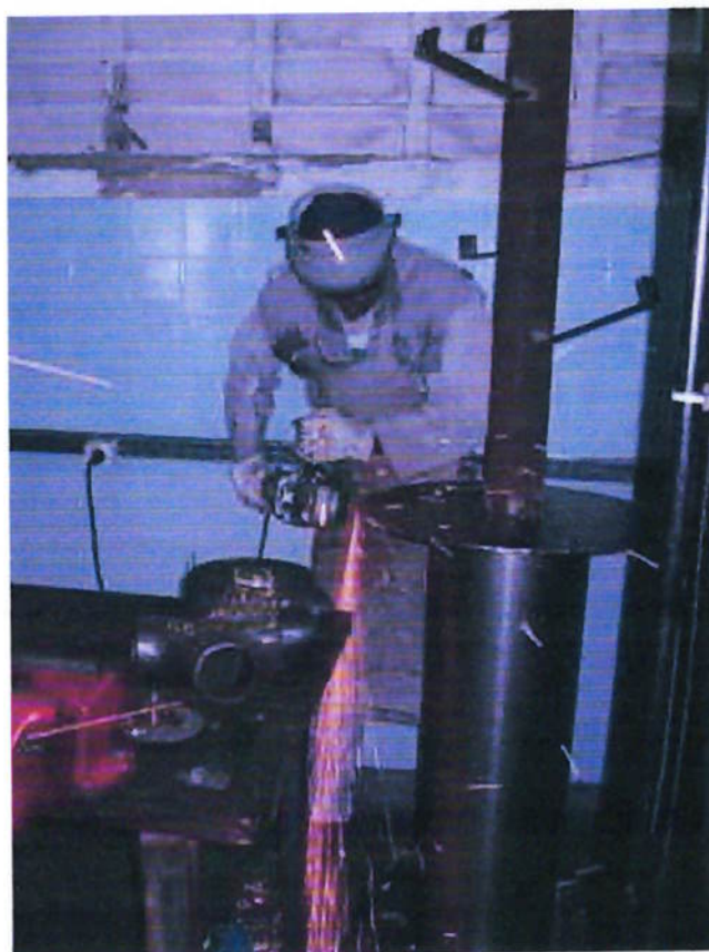
Figura 3 – Montagem e ajuste do conjunto (fonte: Abramam)
