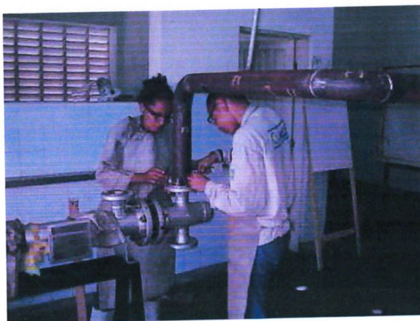
Figura 6 – Pequenos pontos de solda e ajuste do conjunto (fonte: abraman)
